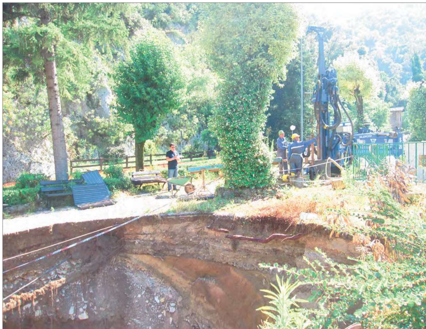
FIGURA 8. Voragine occorsa nel giugno 2013 al margine dell'abitato di Subiaco in Via dei Monasteri (S.R. 411), per il cedimento strutturale della galleria di collettamento del fosso delle Cammore (foto A. Argentieri luglio 2013).
