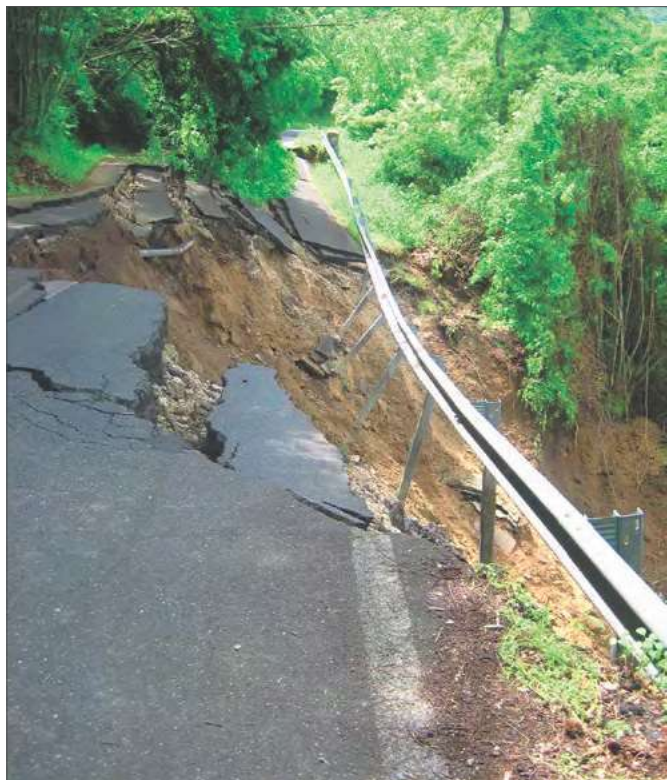
FIGURA 5. Frana nelle unità arenaceo-pelitiche della Formazione di Frosinone al km 24+250 della S.P. Empolitana (foto A. Argentieri maggio 2008).
