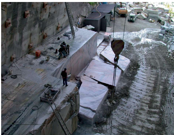
Fig. 4 - Cava in galleria di marmo di Candoglia, Val d'Ossola. - Candoglia's marble tunnel quarry, Ossola Valley.
